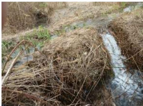
**Figure 10 : GH08 - Restaurer le système d'irrigation gravitaire. Brèche dans le canal.**
